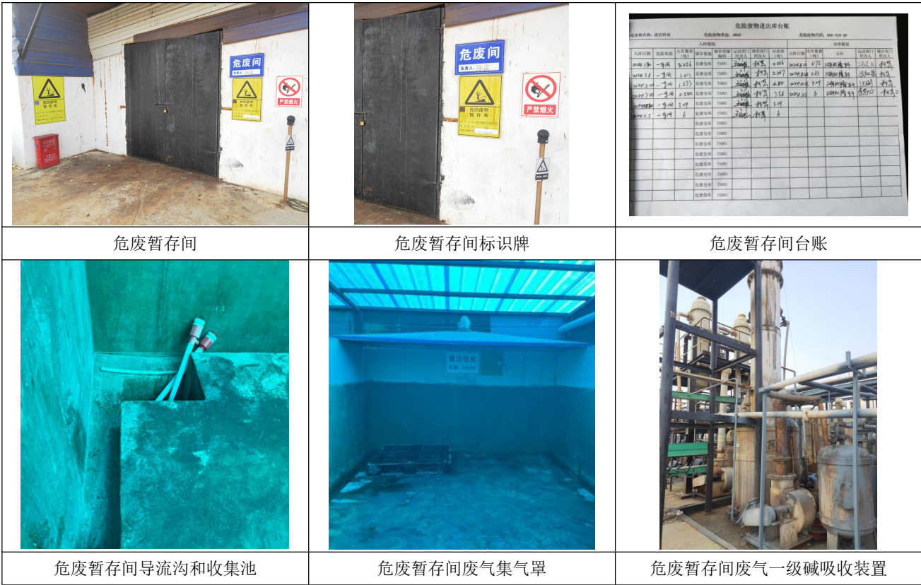
图 4.1-6 厂区危废暂存间建设图
