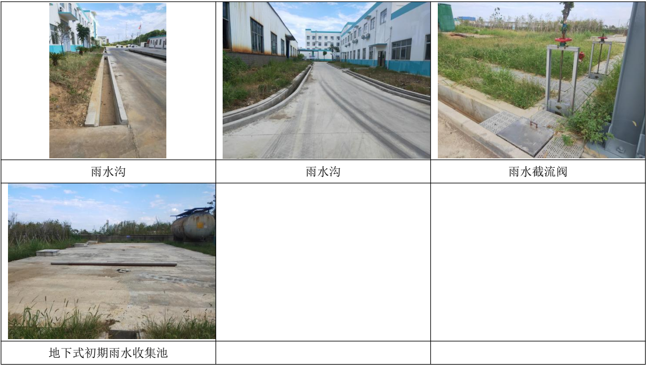
图 4.1-3 厂区初期雨水收集系统图
